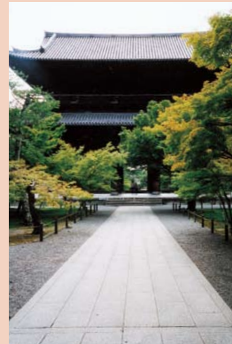
南禅寺。臨済宗南禅寺派の大本山。三門(重要文化財)は五間三戸二階二重門の規模で左右に山廊をもち、禅宗(唐)様からなる雄大な建築である。(撮影：高橋 徹)
